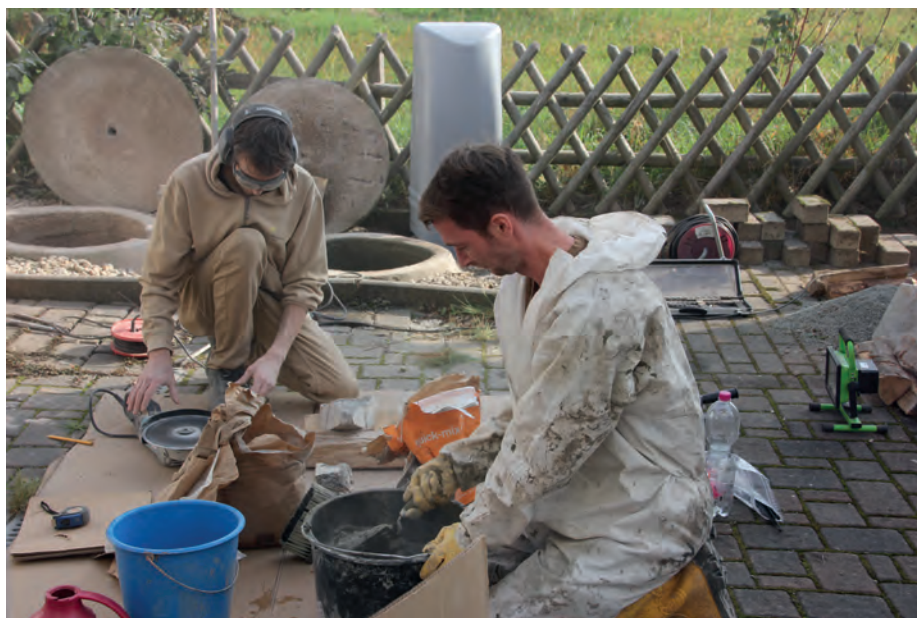
Kai (r.) Radziej und sein Bruder René von der Firma Gerd Radziej bei Arbeiten zur Nachrüstung einer vollbiologischen Kleinkläranlage auf einem Seligenstädter Grundstück.
